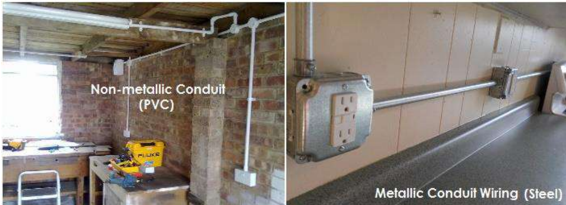
Surface Conduit Wiring
